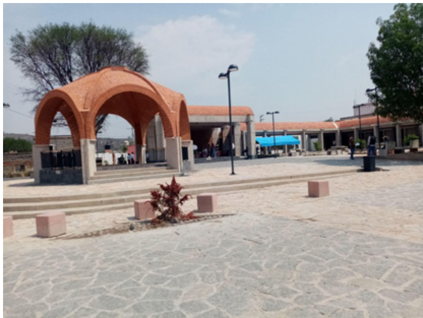
Figura 1. Imagen de las obras del Plan de Justicia en la plaza central de Acasico
