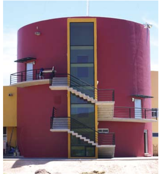
Instalaciones de escaleras de emergencia y el montacargas.
